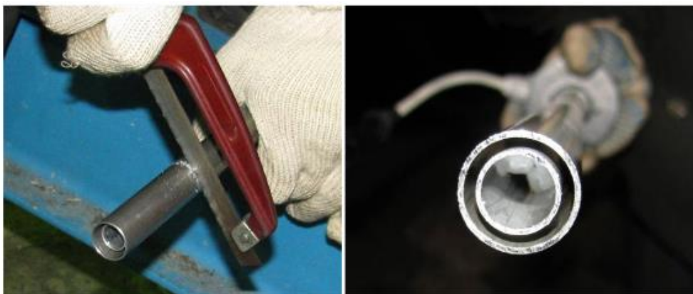
4 pav. Matuoklės vamzdelio atpjovimas
